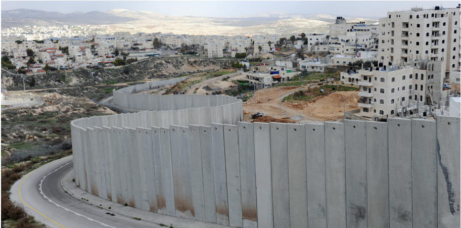
Fig. 5. Muro de Cisjordania
