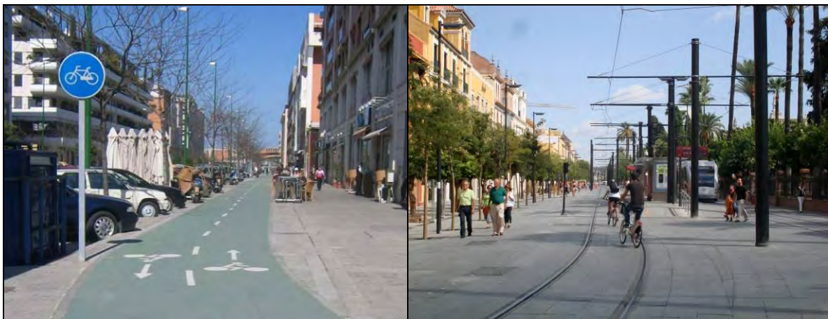
Figura 4: Segregación mediante carril-bici (izqda.), y coexistencia con peatones y transporte público. Fuente: Izqda. www.carrilesbicisevilla.blogspot.com . Dcha: realización propia (2009).
