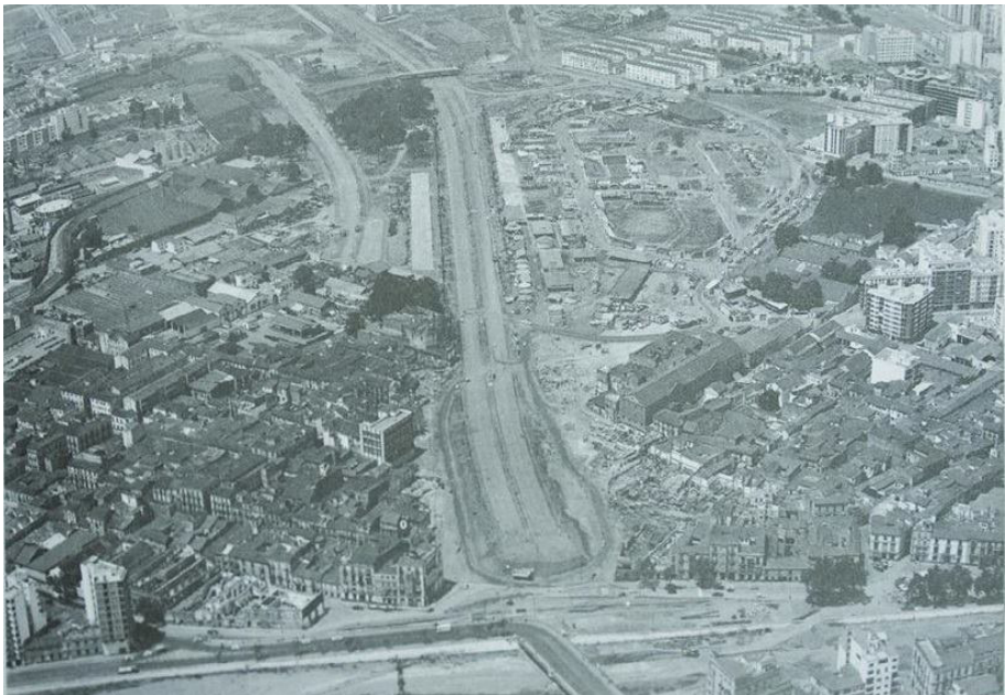
Fig. 6. Vista aérea de la Prolongación de La Alameda en obras. Málaga 1969
