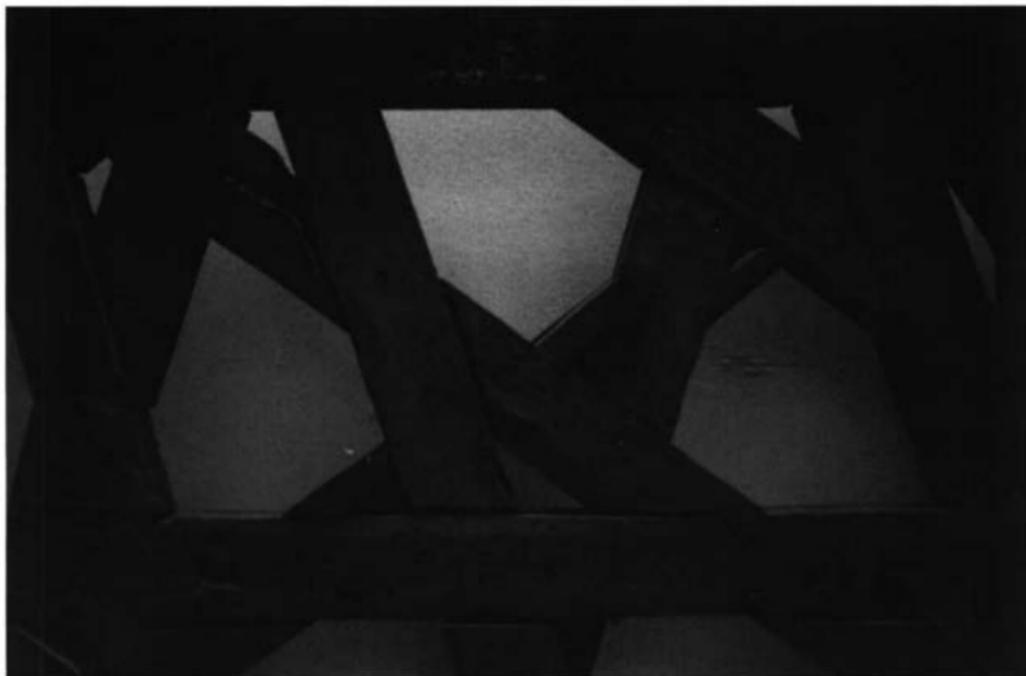
Fotografía 5. Fragmento de la estructura de un almizate decorado con lazos de 8 occidental apeinado del palacio de los Condes de Gelves. (I.G. N° 435).
