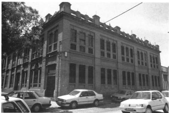
Lámina 4.- Fachada a la calle Los Polancos de la fábrica de sedas sita en la Avda. de Miraflores, Sevilla, Antonio Gómez Millán, 1916-1917.
