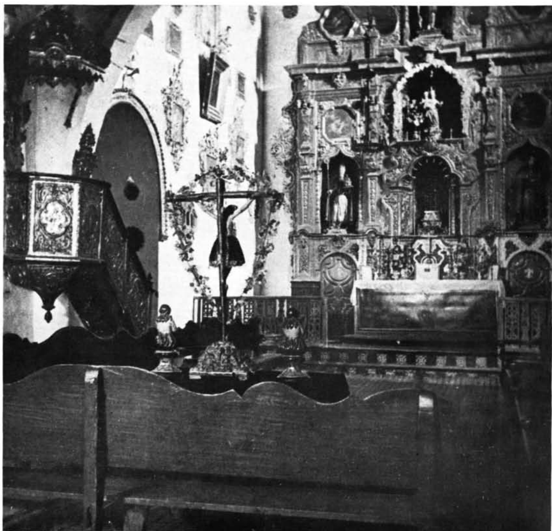
Capilla mayor de la iglesia de San Luis, edificada en la Aljama de la Pureza, antes del incendio de 1933. (Foto del Archivo particular de Luis Núñez Contreras).
