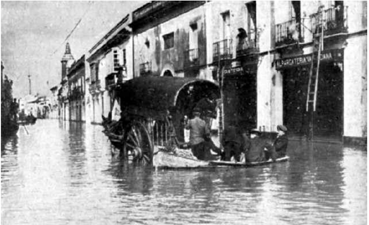
Figura 2.27. Fotografía de las inundaciones de la C/ Castilla
