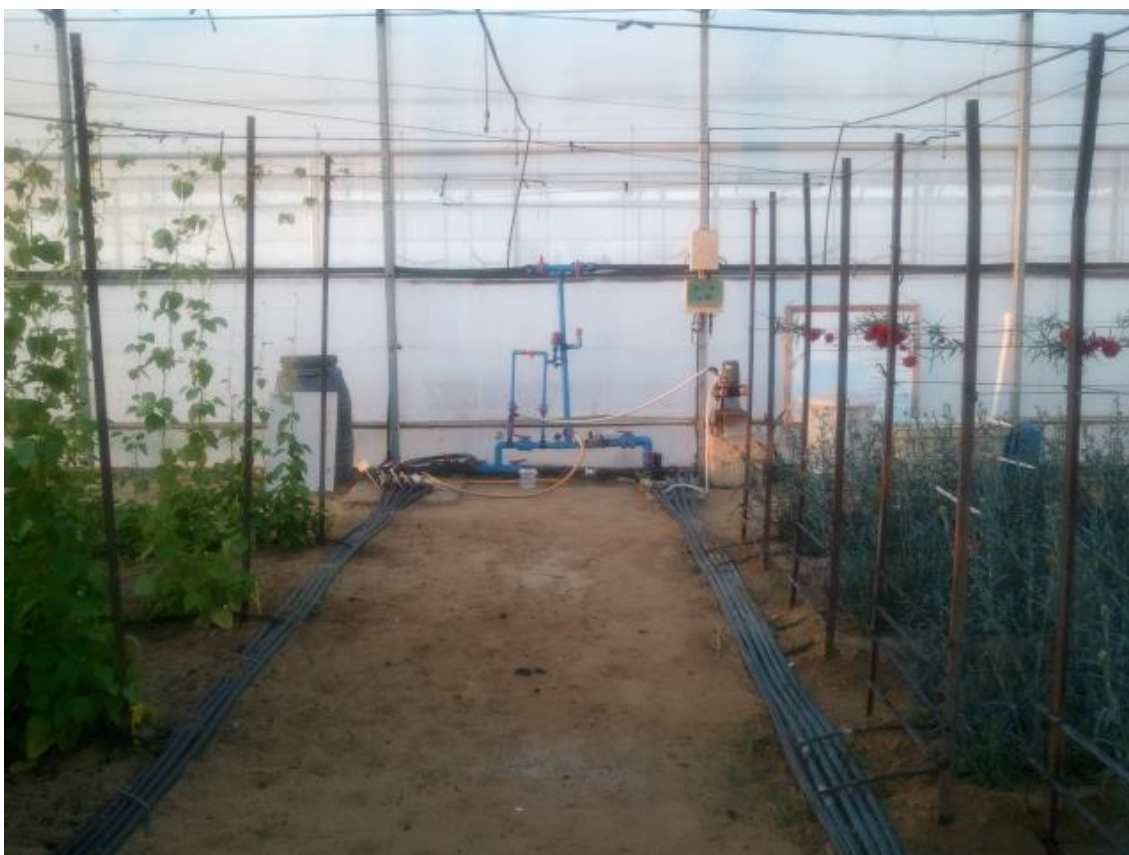
Imagen 11. En la imagen se aprecia el sistema de riego localizado utilizado en el ensayo: laterales, portilaterales, microaspersores, mallas de siembra y entutorado, electroválvulas y programador de riegos.
