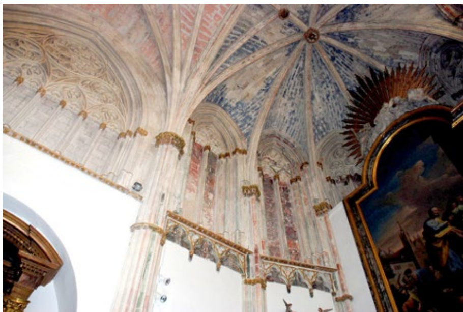
Figura 2. Catedral de Toledo. Muro del evangelio de la capilla de San Pedro.
