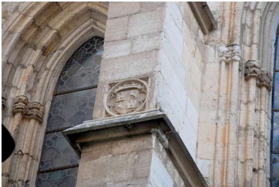
Figura 6. Catedral de Toledo. Exterior de la capilla de San Pedro (detalle).
