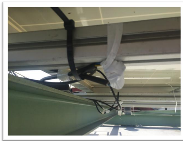
Ilustración 65: Sujeción empalme cables al módulo.
