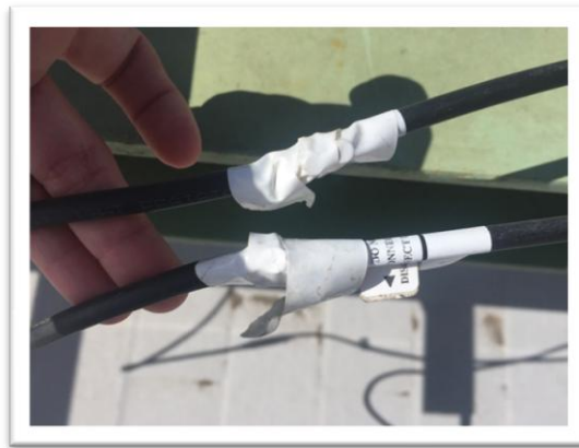
Ilustración 64: Empalme cables instalación.
