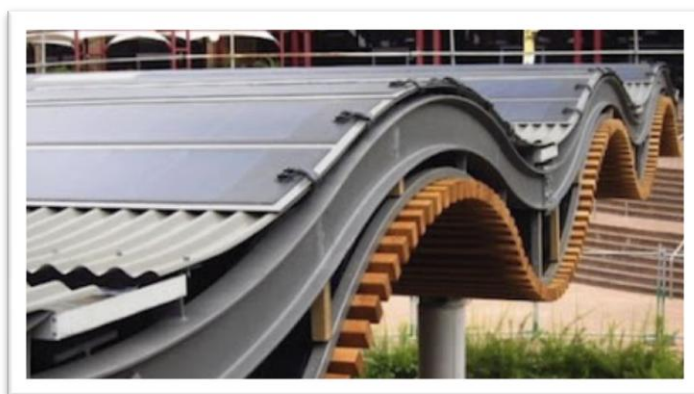
Ilustración 5: Tejado con orientación y/o inclinación dificultosa.[4]
