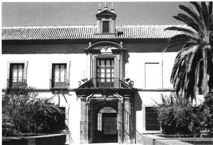
Fachada norte del patio de doña María de Padilla.
