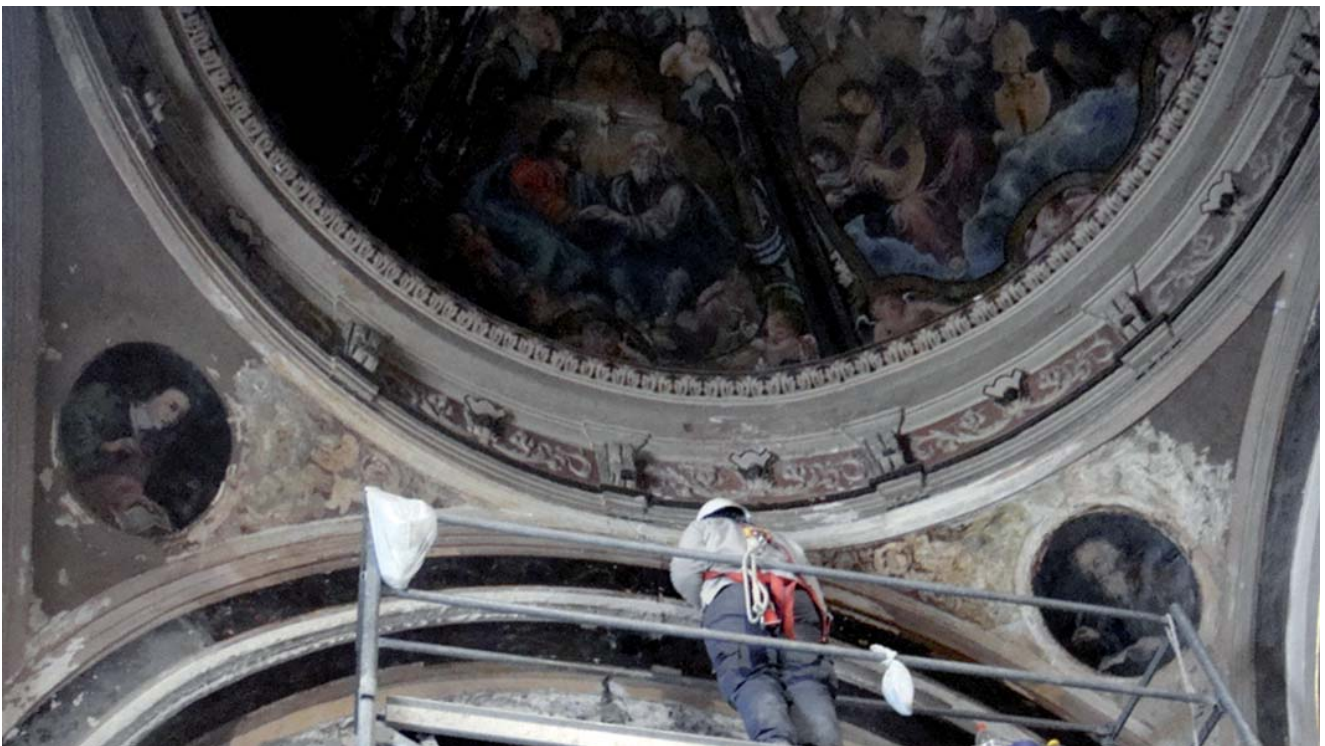
Proceso de eliminación de repintes en las pechinas del presbiterio. Los tondos de los evangelistas, así como todo el tambor de la cúpula, estaban cubiertos con una espesa capa de pintura industrial. Al eliminarla se descubrió una magnífica decoración floral y vegetal que se ha restaurado y recuperado.
