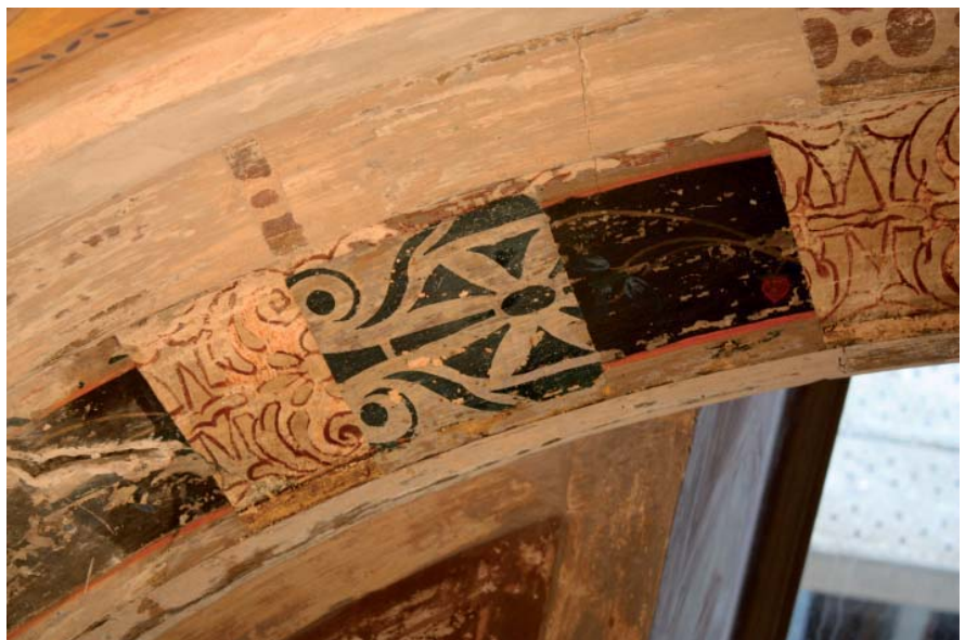
Al realizar los estudios estratigráficos en las superficies pictóricas se ha podido constatar que bajo la capa visible existen otras dos policromías anteriores a la actual, por su estilo y características, es probable que haya sido pintada durante el siglo XIX.
