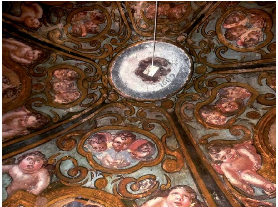
La fecha de terminación de la cúpula fue 1669, dato que apareció cuando se desmontó el pinjante de la cúpula del presbiterio para restaurarlo.
