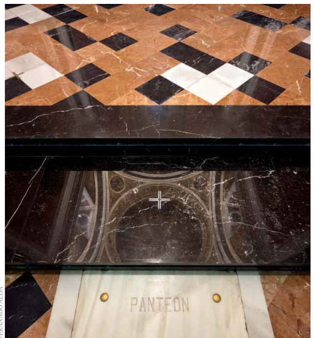
Detalle del pavimento. La lápida de la familia Escovedo, que aún permanece sepultada en la cripta, ha sido restaurada y repuesta en su lugar original. El suelo que había en la Capilla era de terrazo de grano grueso de muy mala calidad, había sustituido al original de mármol blanco y negro. Algunas de estas baldosas originales aparecieron al levantarlo y se han vuelto a poner en la zona de la puerta principal de la Capilla. El resto del suelo de la Capilla comienza con el color blanco de la capilla gótica y se va transformando paulatinamente en rojo hasta llegar al altar mayor. A lo largo de su superficie se han dispuesto una serie de cruces que son rejillas de ventilación de la cámara sanitaria y los muros.
