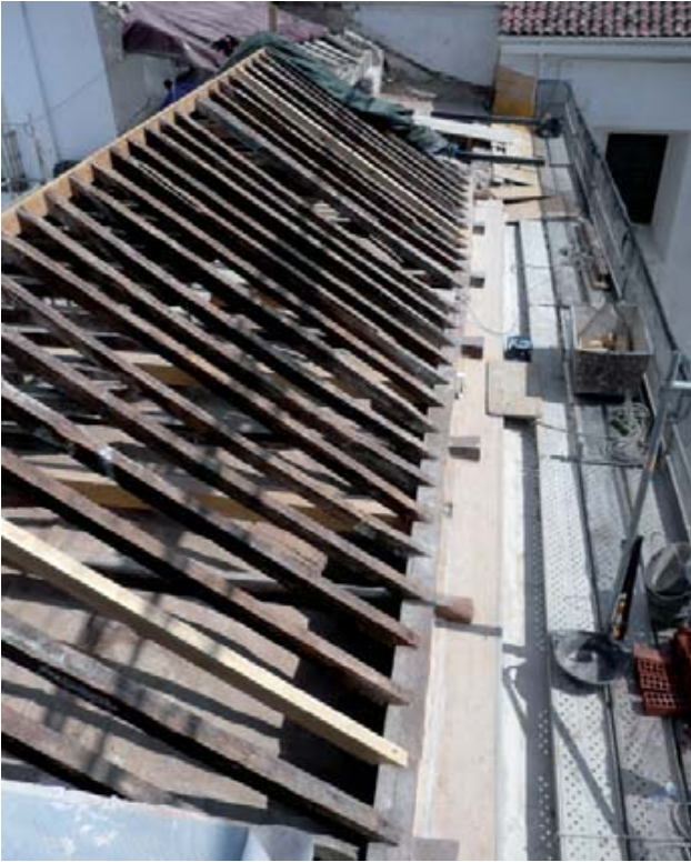
Aspecto del zunchado de los muros con maderas de viga laminada anclada con varillas de acero inoxidable. Este atado en las cabezas de los muros sigue permitiendo flexibilidad a sus fábricas para que puedan adaptarse a futuros movimientos sin rigidizarlas en exceso, evitando su posible rotura en los puntos más débiles.
