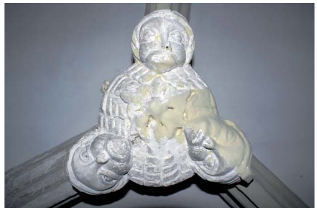
Detalle de la decoración de la bóveda gótica. La eliminación de la gruesa capa de pintura permitió que aparecieran detalles y dibujos que no eran posibles apreciar correctamente. La policromía original se encuentra completamente perdida, a excepción de algunas cabezas, muy puntuales, que aún conservan restos en ojos y comisuras de los labios.
