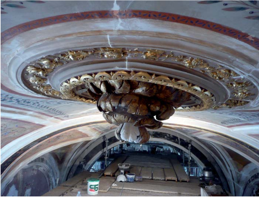
Proceso de limpieza del pan de oro en el pinjante central, con el estucado y reposición de las partes perdidas.
