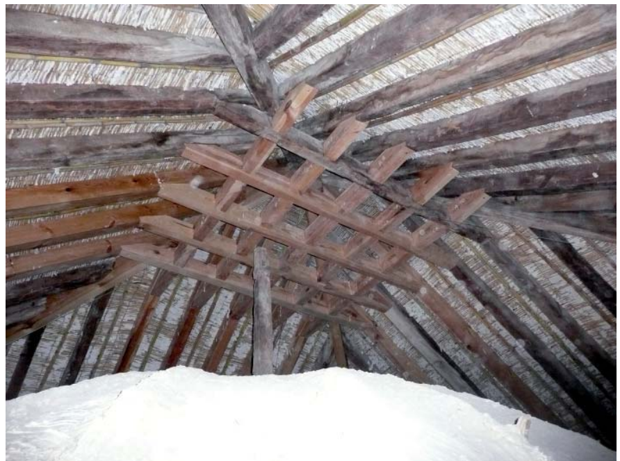
Montaje definitivo de la armadura de madera sobre la cúpula del presbiterio. Se puede observar el nuevo almizate que incluye la única pieza que se ha podido reutilizar de todas las originales. El palo de madera que asoma por la parte alta de la cúpula es el armazón del pinjante central de la cúpula.
