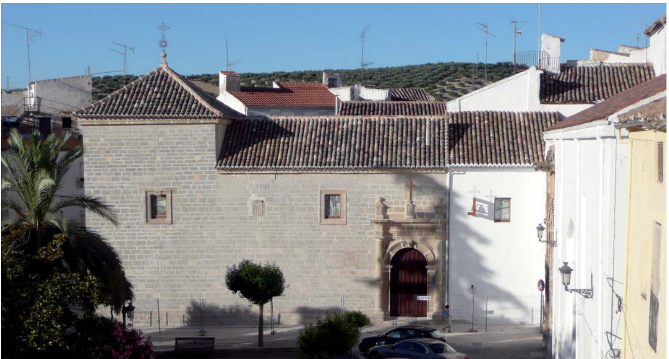
Fachada de la Capilla de Jesús. En esta restauración, hemos mantenido aspectos que evocan el paso del tiempo, conservando las grietas existentes que han quedado como cicatrices en el edificio consecuencia del transcurrir del tiempo. Se ha dejado visible el desnivel de la cornisa exterior del presbiterio, que alcanza los 20 cms. entre sus dos extremos de la plaza de la Constitución. En definitiva, hemos asumido una “imperfección inteligente” que ha buscado recuperar, mantener los antiguos materiales y las pequeñas cosas que evocan el paso del tiempo, considerándolo como un material de construcción más, que tiene y debe ser visible.
