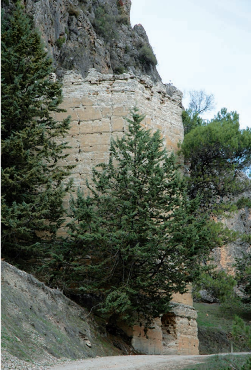
Fig. 9.- Torre del Agua.
