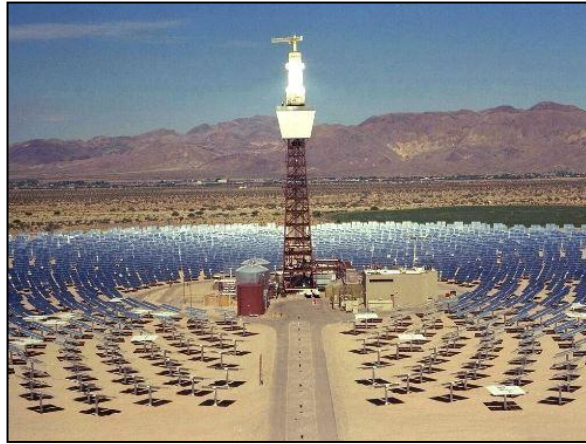
Figura 39: Sistema de torre solar. [33]
