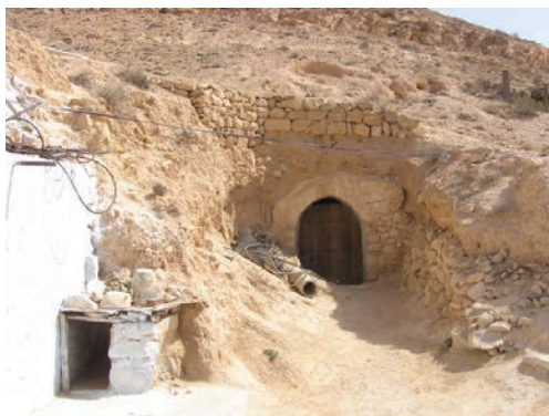
Foto 6. Entrada al molino subterráneo
