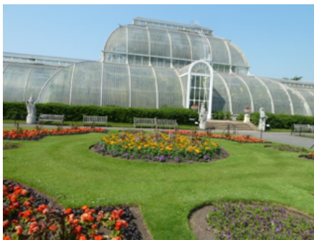
Palm House, Kew Garden, Londres. Palacio de Cristal, Parque del Retiro, Madrid.
