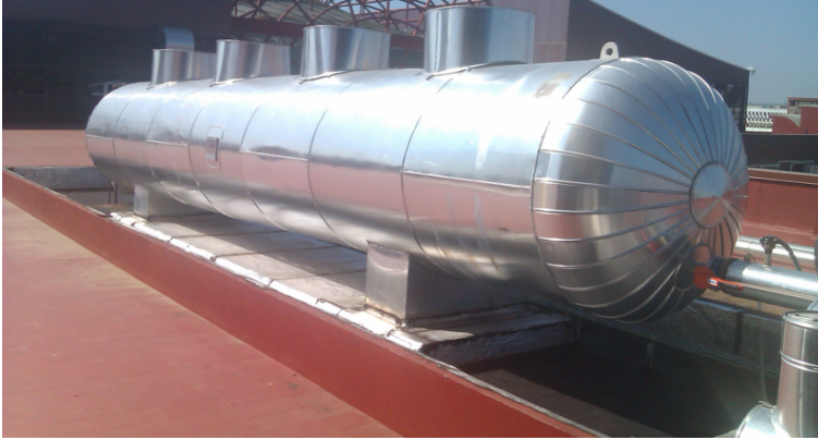
Figura 6.3: Tanque de almacenamiento basado en PCM
