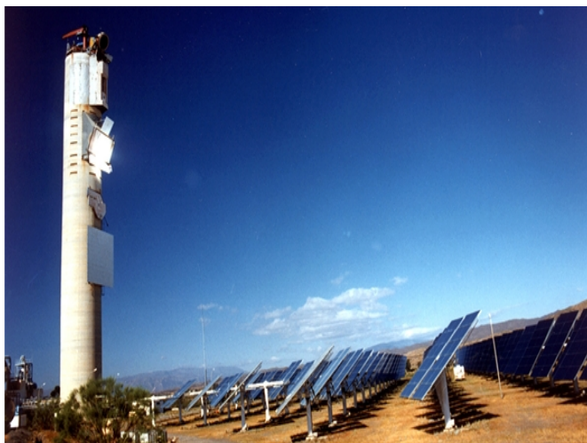
Figura 7.1: Planta solar de Torre CESA-1 (cortesía de la PSA)
