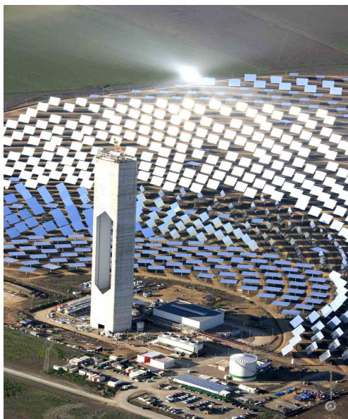
Figura 1.2: Abengoa PS20: Planta solar de torre de 20 MW (cortesía de Abengoa Solar)
