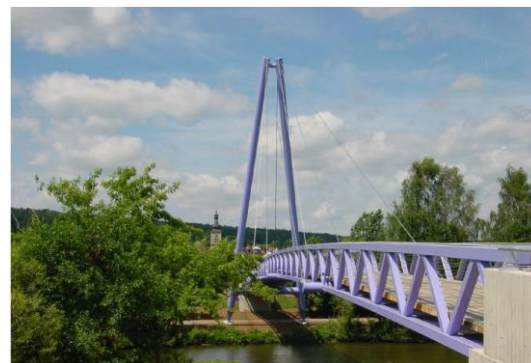
Figura 2.20 Puente de Forchheim (Alemania).
