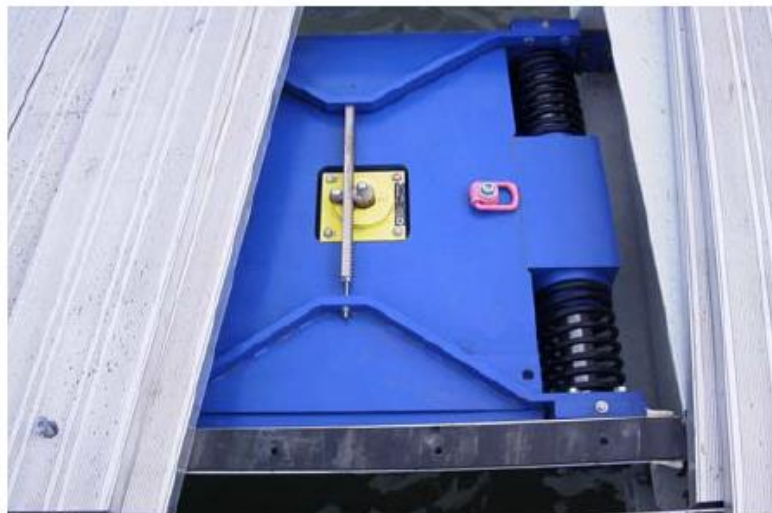
Figura 2.27 TMD horizontal en su colocación final.
