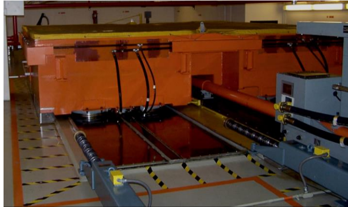
Figura 2.3 TMD de la torre John Hancock.
