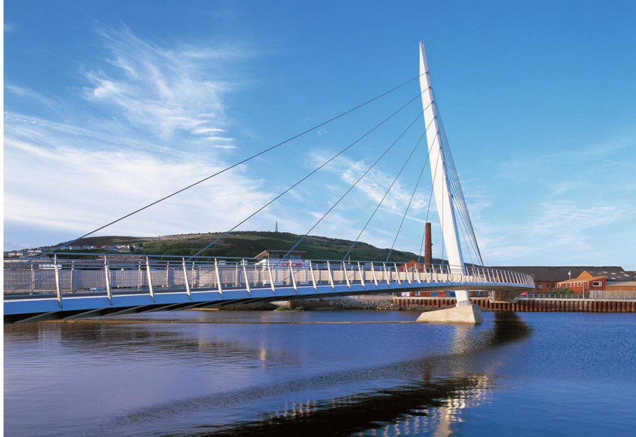
Figura 2.25 Puente Port Tawe en Swansea, Reino Unido.
