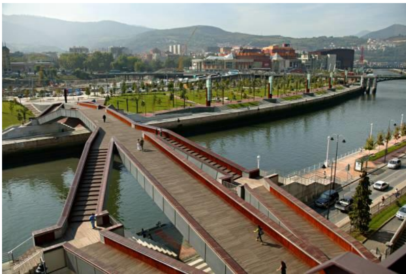
Figura 2.22 Vista general de la pasarela de Pedro Arrupe, Bilbao.
