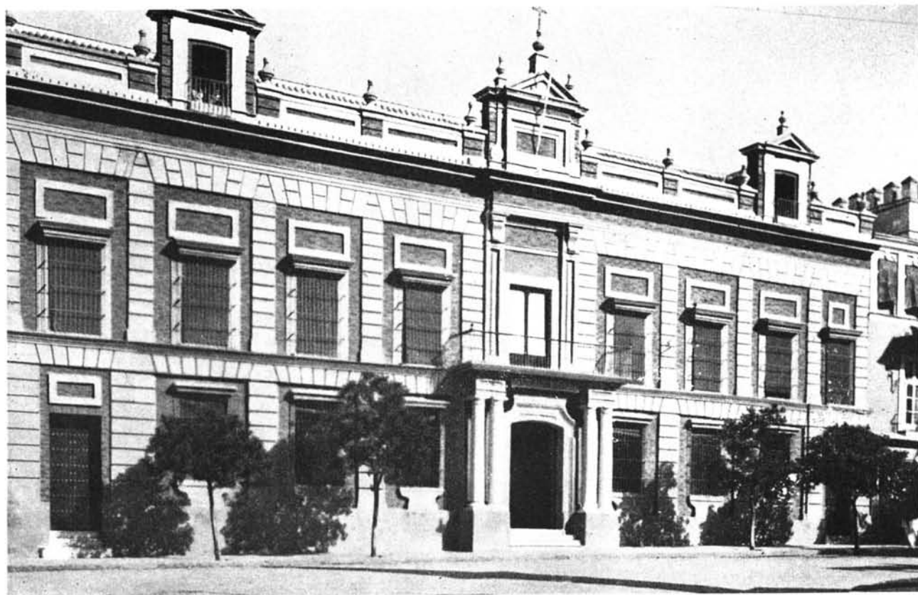
Antigo palacio de Irureta Goyena actual sede de la Diputación Provincial de Sevilla
