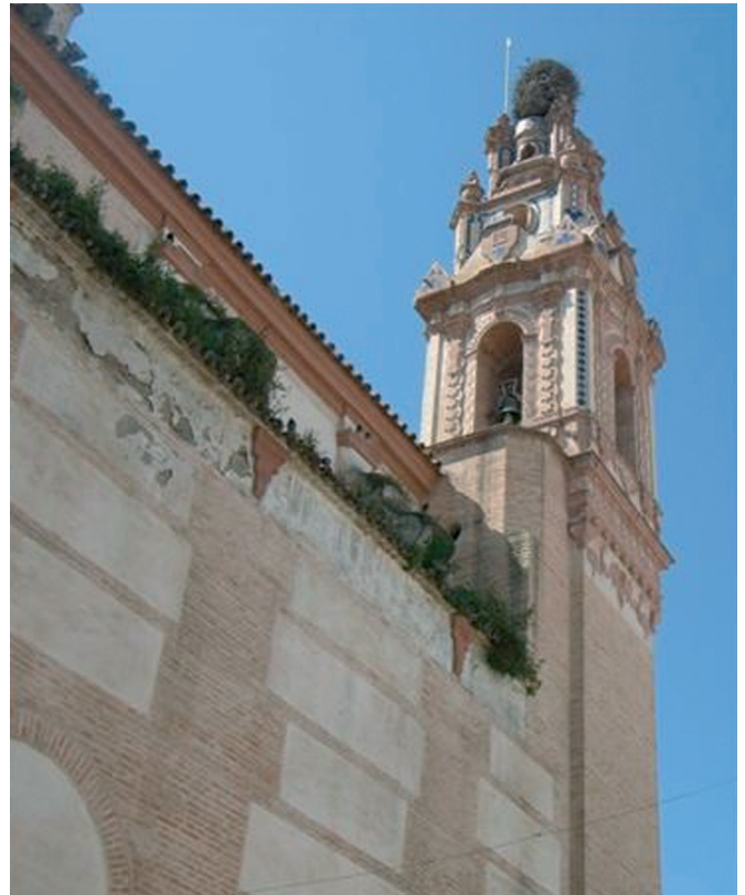
Fig. 24. Iglesia de Santa Ana de Écija, del siglo XVIII (tipo 11: tapial de fraga encadenado y triple verdugado en ladrillo. Variante: de cajón único)
