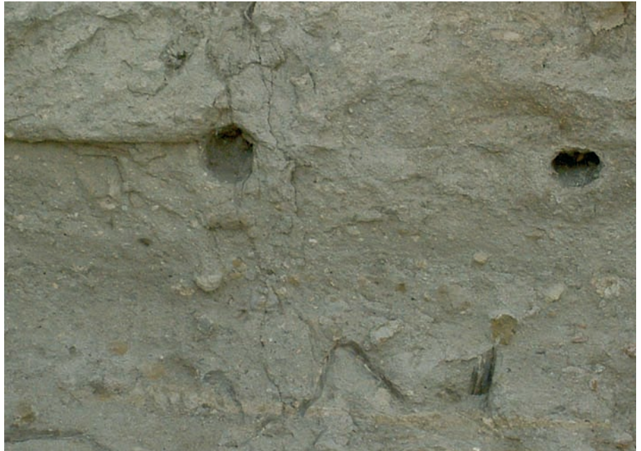
Fig. 9. Detalle de las tongadas de cal en el Mirador almohade de la Muralla de Marchena
