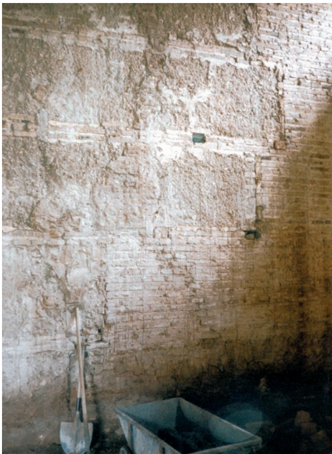
Fig. 20. Detalle de fábrica de tapial en la Casa de Miguel de Mañara, del siglo xvi (tipo 10: tapial de fraga encadenado y doble verdugado en ladrillo)
