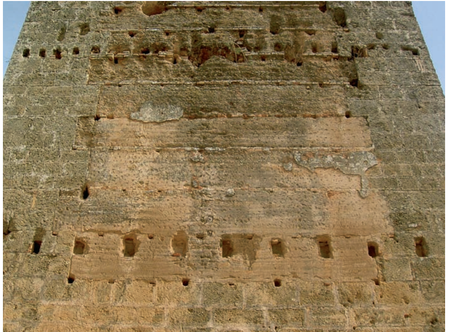
Fig. 15. Torre del Castillo de Alcalá de Guadaíra, del siglo XIV (tipo 7: tapial de fraga encadenado en piedra y verdugado en ladrillo)
