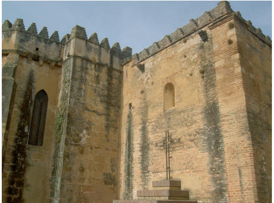
Fig. 17. Ermita de Nuestra Sra. del Águila de Alcalá de Guadaíra, del siglo XIV, reformada tras el Terremoto de Lisboa, con cajones de mampostería ejecutados con tapiales del Castillo de la localidad
