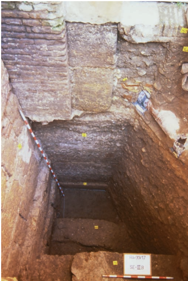
Fig. 4. Muralla del Agua del Alcázar de Sevilla: lienzo abbadí, de mediados del siglo XI (tipo 1: tapial común)
