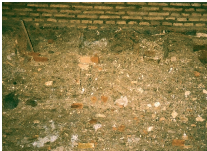
Fig. 21. Detalle de argamasa de fábrica de tapial en la Casa de Miguel de Mañara. Siglo XVI. Se aprecian los nódulos de cal y los restos de carbón
