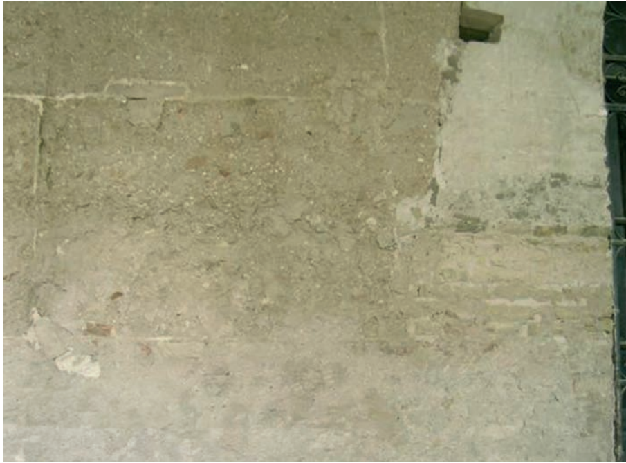
Fig. 19. Detalle del Claustro del Convento de Santa Clara, de fines del siglo xv (tipo 4: tapial encadenado en ladrillo, variante: con remate latericio)
