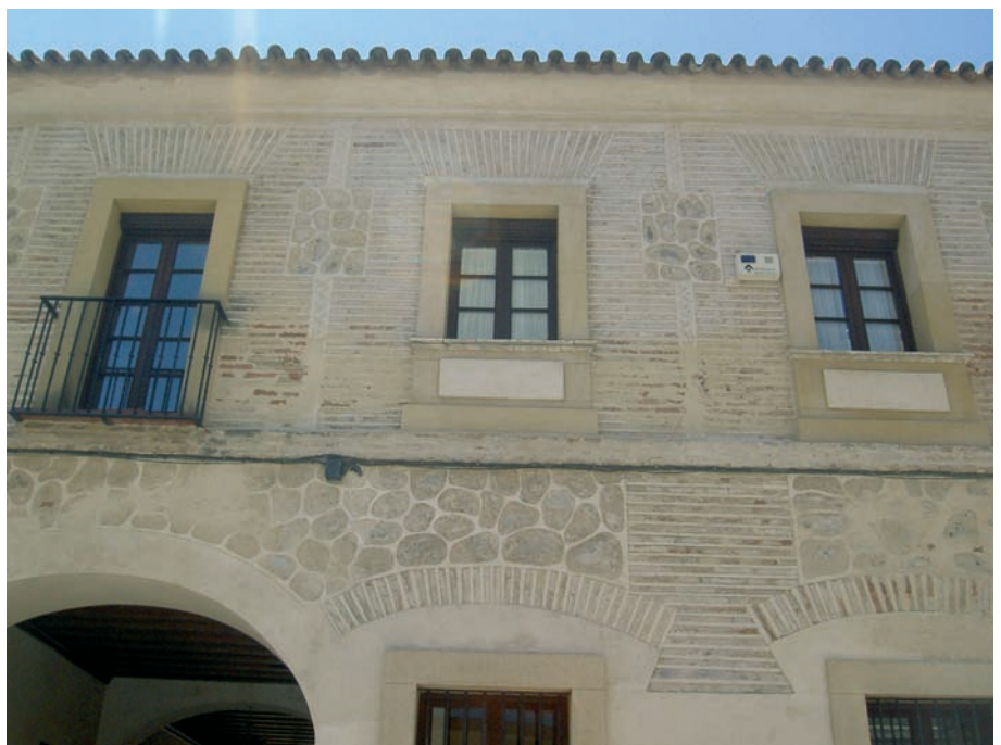
Fig. 18. Viviendas de la Calle Habana de Sevilla (Casa de la Moneda), construidas por Sebastián Van der Borch tras el Terremoto de Lisboa, con cajones de mampostería toledana ejecutada con tapiales de la muralla almohade
