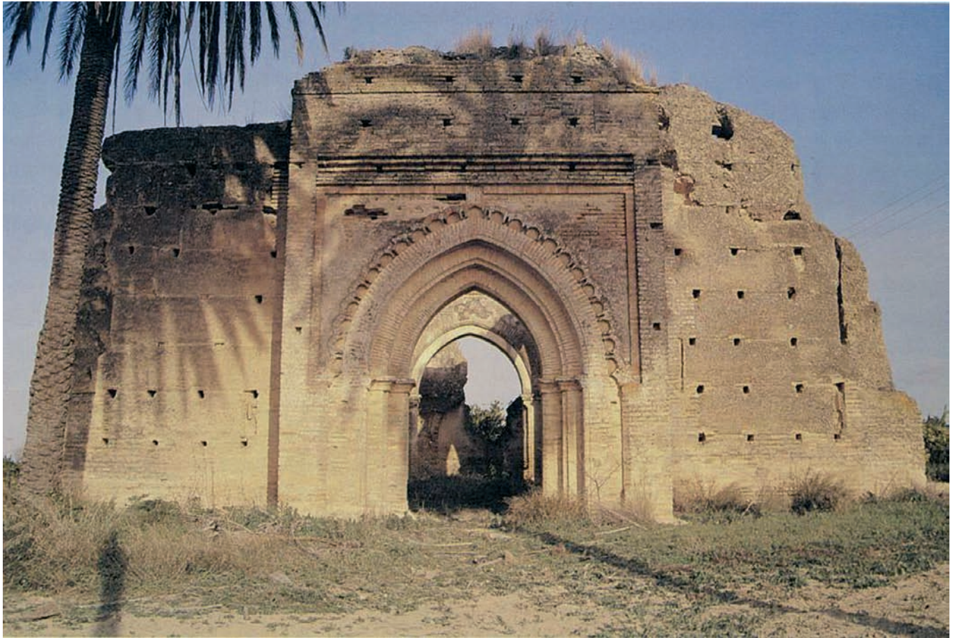
Fig. 10. Ermita de Talhara (Benacazón), del siglo XVI (tipo 4: Tapial encadenado en ladrillo)
