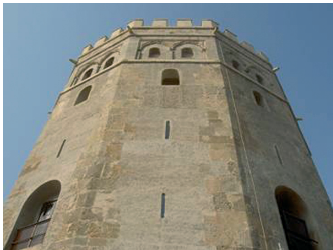
Fig. 7. Torre del Oro. Albarrana de la coracha del Alcázar, fechada en 1221 (tipo 5: tapial encadenado en piedra)
