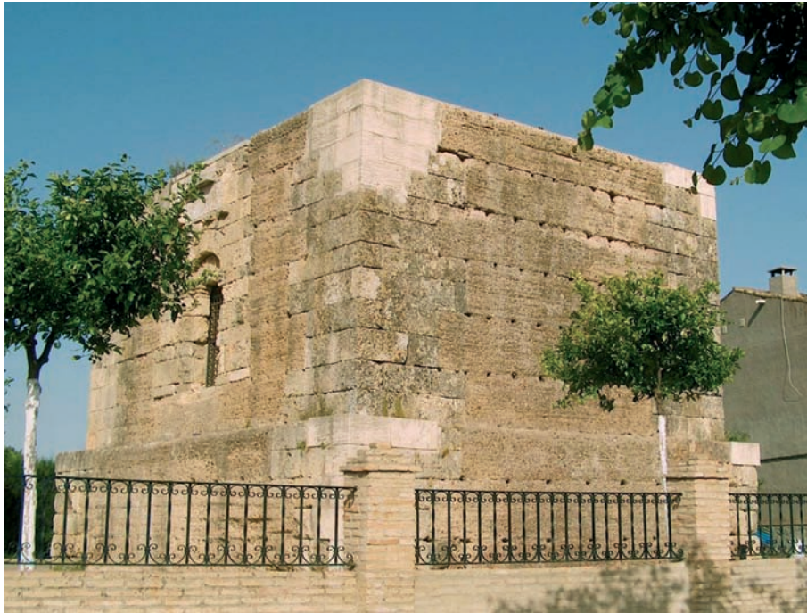
Fig. 13. Torre Mocha de Albaida del Aljarafe, de la segunda mitad del siglo XIII (tipo 5: tapial encadenado en piedra)
