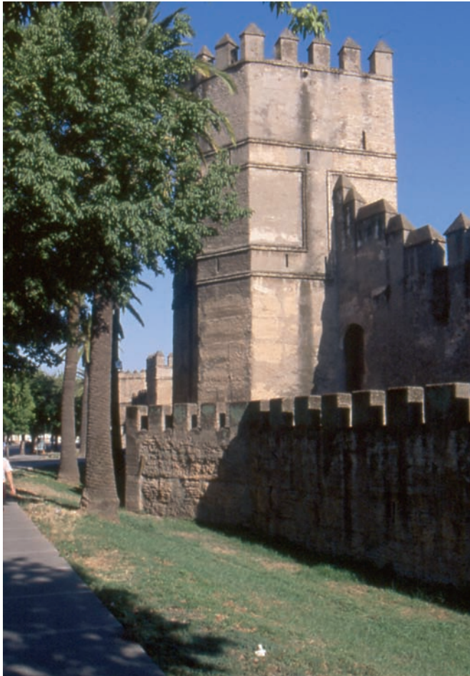
Fig. 5. Muralla de Sevilla, tramo de la Macarena: la cerca, de mediados del siglo XII; el antemuro, de 1212. (Lienzos, tipo 1: tapial común / torres, tipo 2: tapial verdugado en ladrillo)
