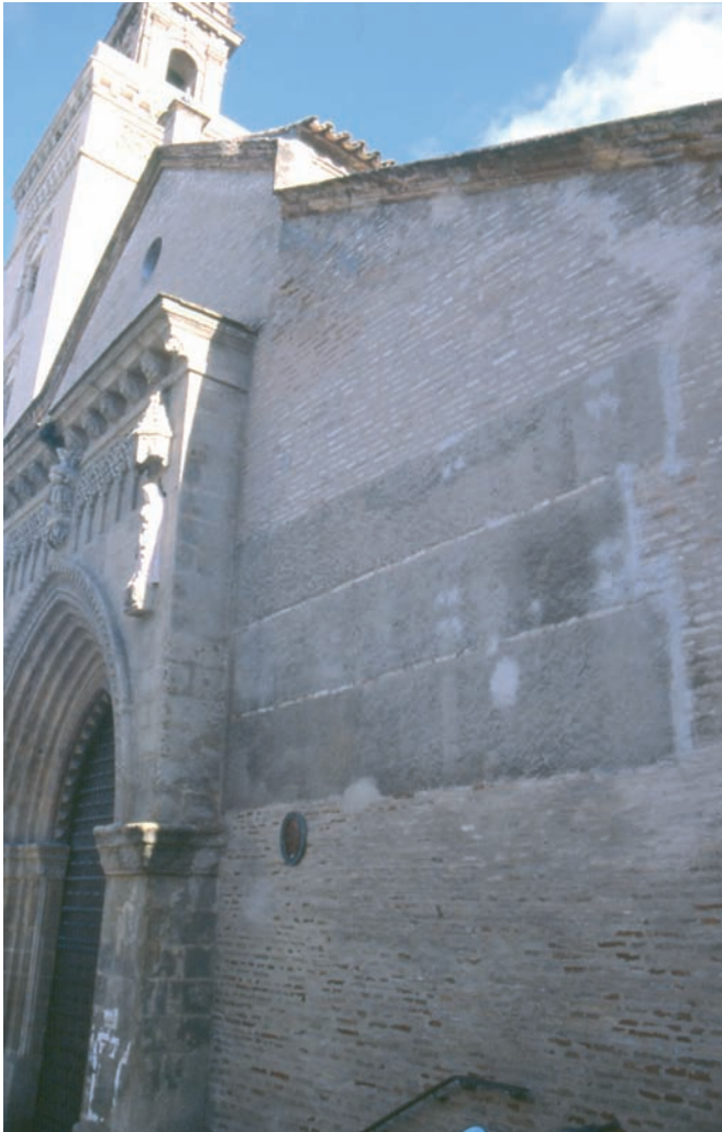
Fig. 11. Fachada Oeste y portada de la Iglesia mudéjar de San Marcos, de mediados del siglo XIV (tipo 9: tapial de fraga encadenado y verdugado en ladrillo)
