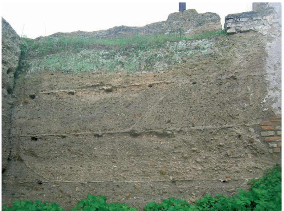
Fig. 16. Paramento del Mirador Almohade de la Muralla de Marchena del Alcor, ejecutado con tapiales yuxtapuestos, del siglo XIII
