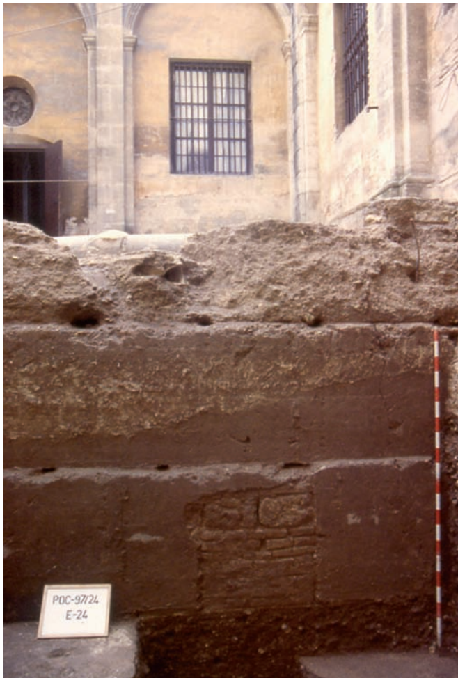
Fig. 8. Muralla almohade junto a la quibla de la mezquita aljama, levantada en 1172 (tipo 4: tapial encadenado en ladrillo)
