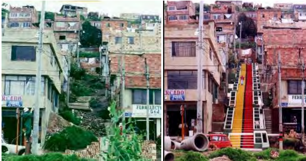
Figura 13. Obras con saldo Pedagógico. Barrio Horizontes. Fuente: Departamento administrativo de acción comunal, Bogotá.
