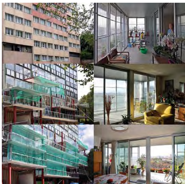
Figura 6. Imágenes de los dos procesos paralelos de transformación interior y exterior. Fuente: Frédéric Druot y Agence Lacaton&Vassal.
