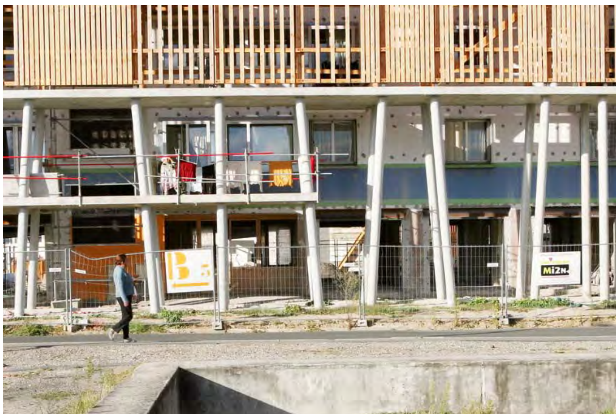
Figura 13. Coexistencia de obra y habitantes en la Manzana B2 de Terres Neuves (Bègles, Comunidad de Burdeos, 2010). Fuente: Bertrand Renaudin.
