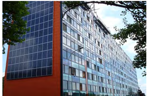
Figura 8. Conjunto habitacional de 133 viviendas HLM construidas en 1965 en la calle Georges Sand de Chenôve (Côte d'Or, Francia). Intervención de reciclaje llevada a cabo en 2009 por el bailleur OPH21 y el equipo de arquitectura Patrick Bidot. Instalación de subestructura de aluminio lacado en fachada que permite el cierre de balcones, y de paneles fotovoltaicos (Tenesol) sobre fachadas ciegas con base de aislante de espuma de poliuretano color naranja. Las 420 placas instaladas en el conjunto proporcionan una potencia media de 47,2 kWh. Un panel digital en la fachada ciega norte informa de la potencia instantánea, la total acumulada y las toneladas de CO2 que se han dejado de emitir a la atmósfera. Fuente: Michel Patois, < www.orbitis.fr >.
