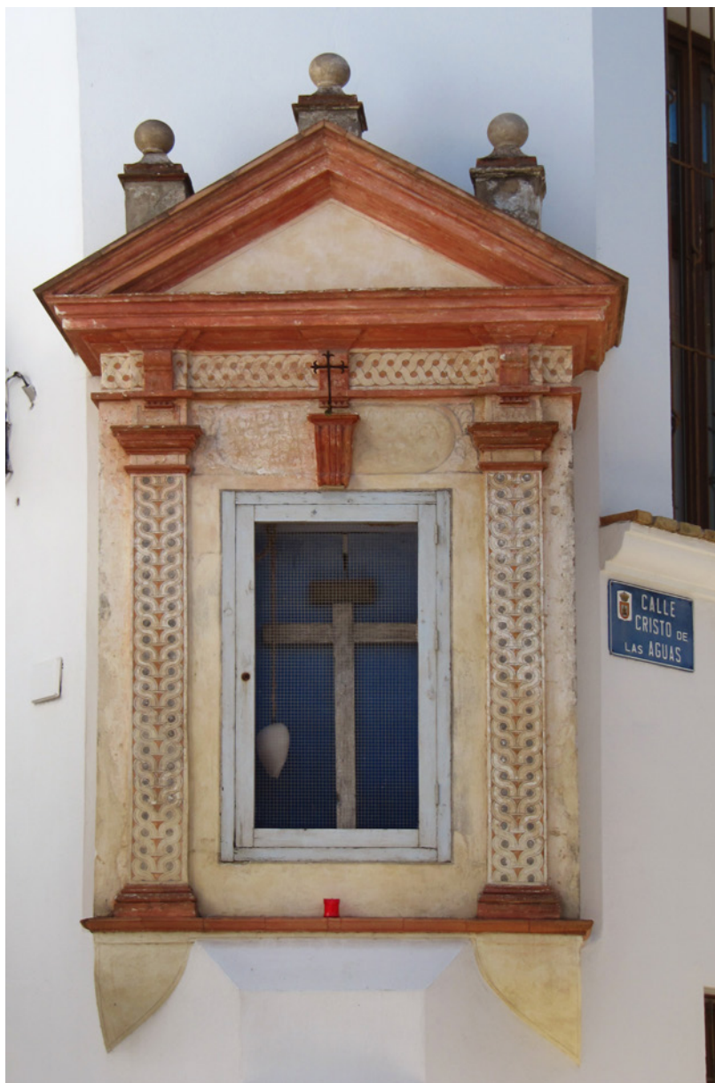
Figura 10. Capilla de la c/ Cristo de las Aguas. Pilastra y friso con eslabones entrelazados dobles.
