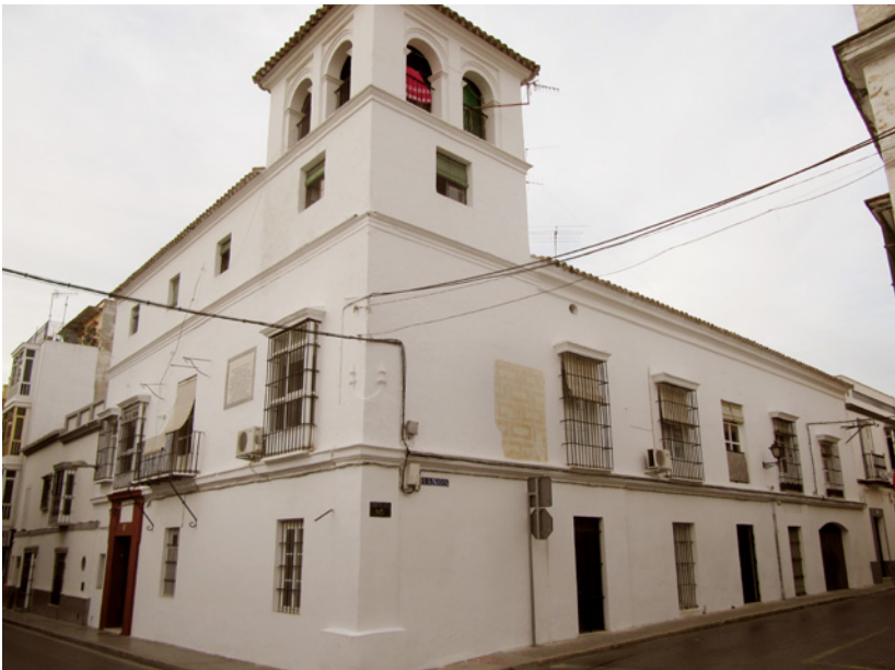
Figura 5. Casa en c/ Ganado nº 10 esquina a Baños. Sillares almohadillados en punta de diamante “de tabla llana”.
