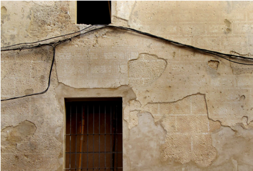
Figura 4. Casa de los marqueses de Arizón. Calle Banda Playa. Superposición de sillares simples y almohadillados. 1712 y posterior.
