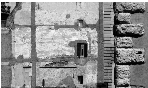
Figura 1. ¿Dónde está el interés patrimonial? En el esquinón de sillería almohadillada, en la esquina renacentista contigua, en el desvencijado testero medianero o en la expresión plástica de su suma. Fuente: Foto cedida por MdLR.
