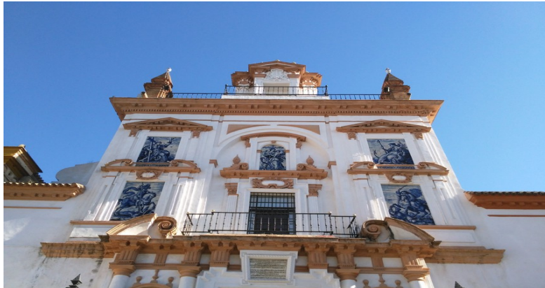
Figura 4.7: Fachada Hospital de la Caridad Fuente: Elaboración propia
