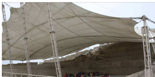
Sistema de cubrición singular con lámina textil en la Huaca del Brujo
