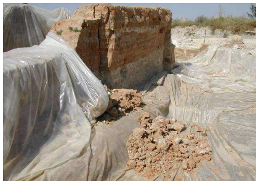
Muros de adobe en el Carambolo actualmente sin protección
