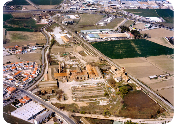
Vista aérea del recinto industrial
