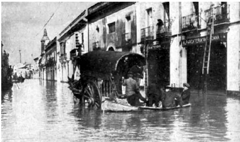
Ilustración 4: Riada del Guadalquivir en 1961 recuperando su lugar en una calle del barrio de Triana (Sevilla). Fotografías de Víctor José González Ramallo
