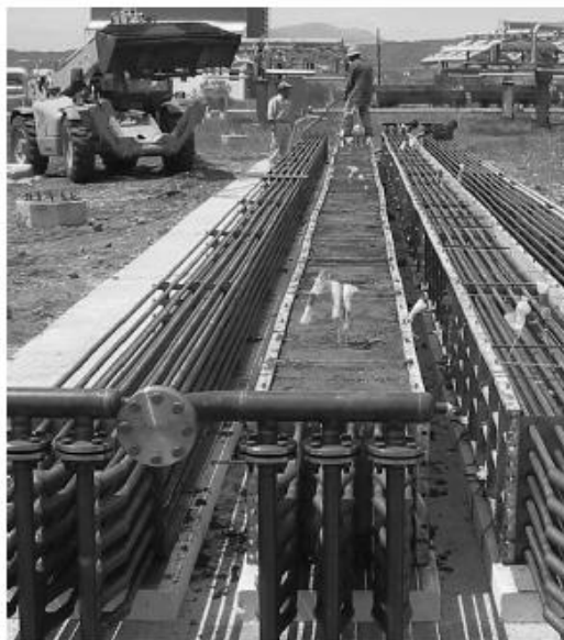
Ilustración 41 Conexión de los intercambiadores de calor en las unidades de almacenamiento [Laing, 2006]
