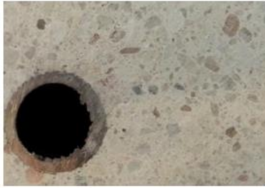
Ilustración 19 Módulo de almacenamiento NEST después del test térmico [Bergan, 2014].
