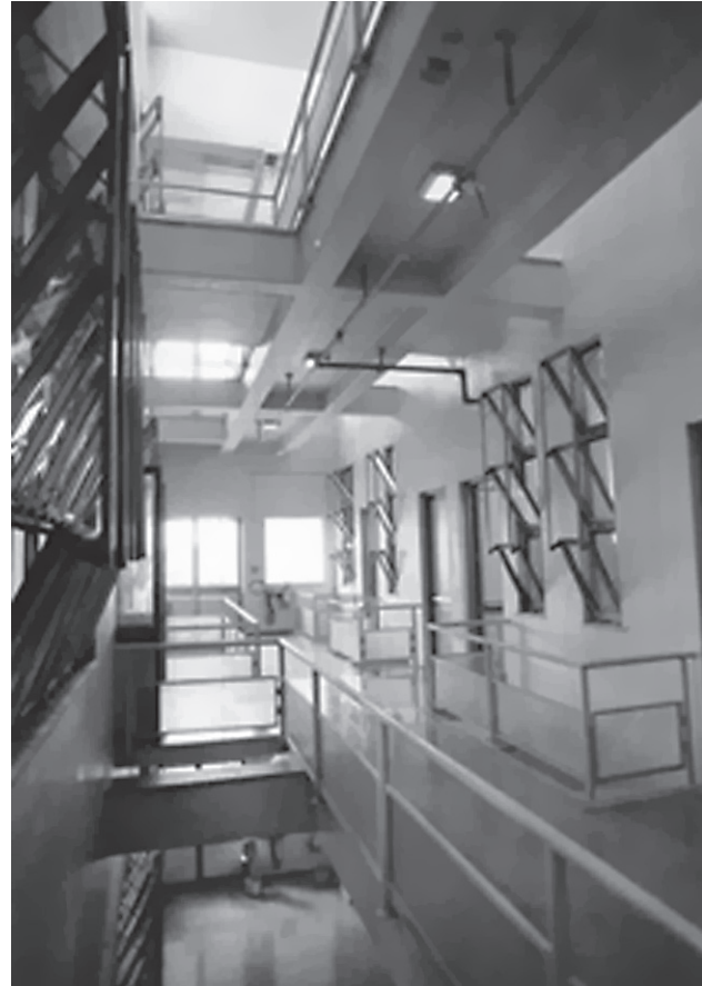
Figura 22: Zona de los laboratorios en la que se pueden observar las aperturas de aire hacia oficinas y laboratorios
