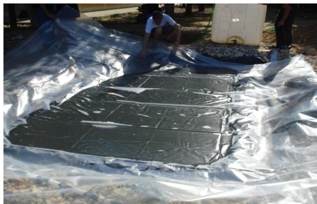
Foto 10. Hermetización del canal.
