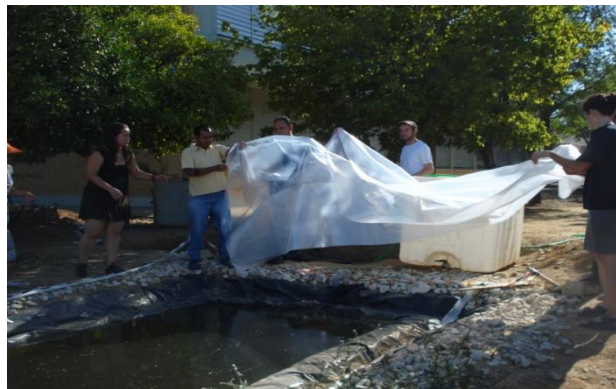
Foto 9. Colocación del plástico.
