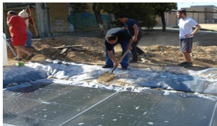
Foto 12. Aseguración del plástico con la ayuda de arena.
