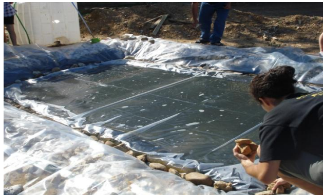
Foto 11. Colocación de las piedras alrededor del plástico.
