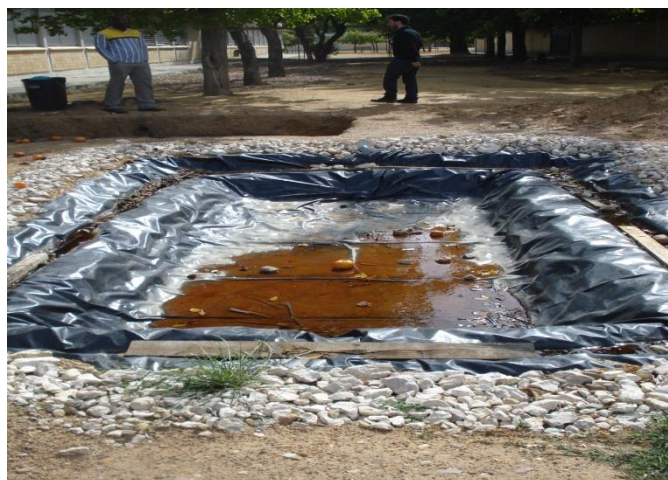
Foto 7. Impermeabilización del canal.
