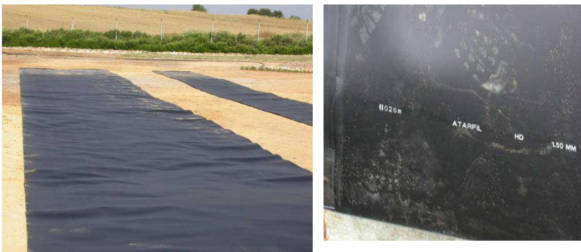
Imagen36. Corte y detalle de calidad láminas de PEAD.
