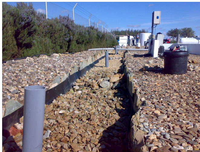
Imagen 34. Instalación de los respiradores en el dren.
