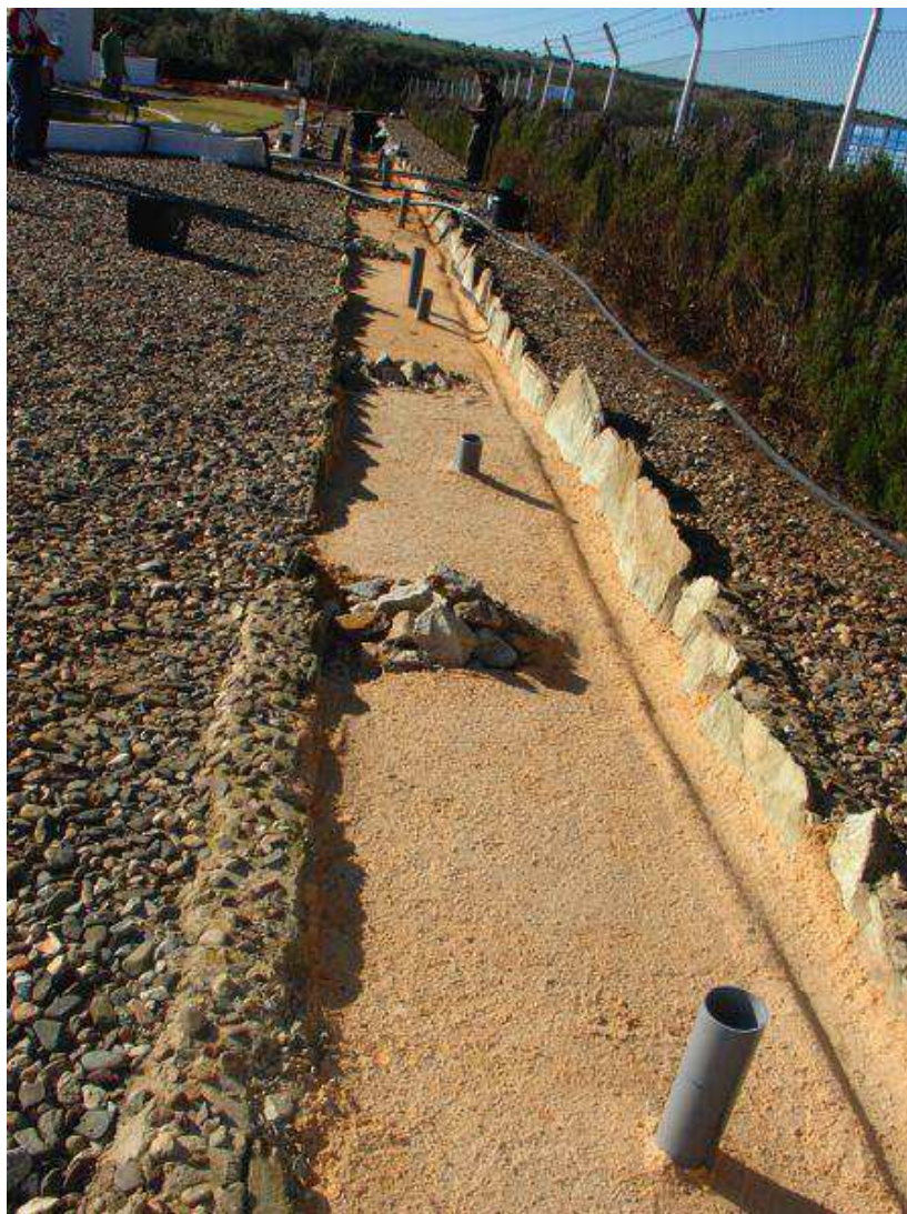
Imagen 12. Dren de Piedras de Aireación forzada en la PECC
