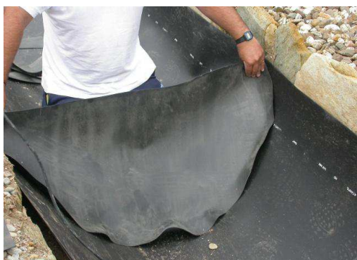
Imagen 26. Colocación tajadera de PEAD.
