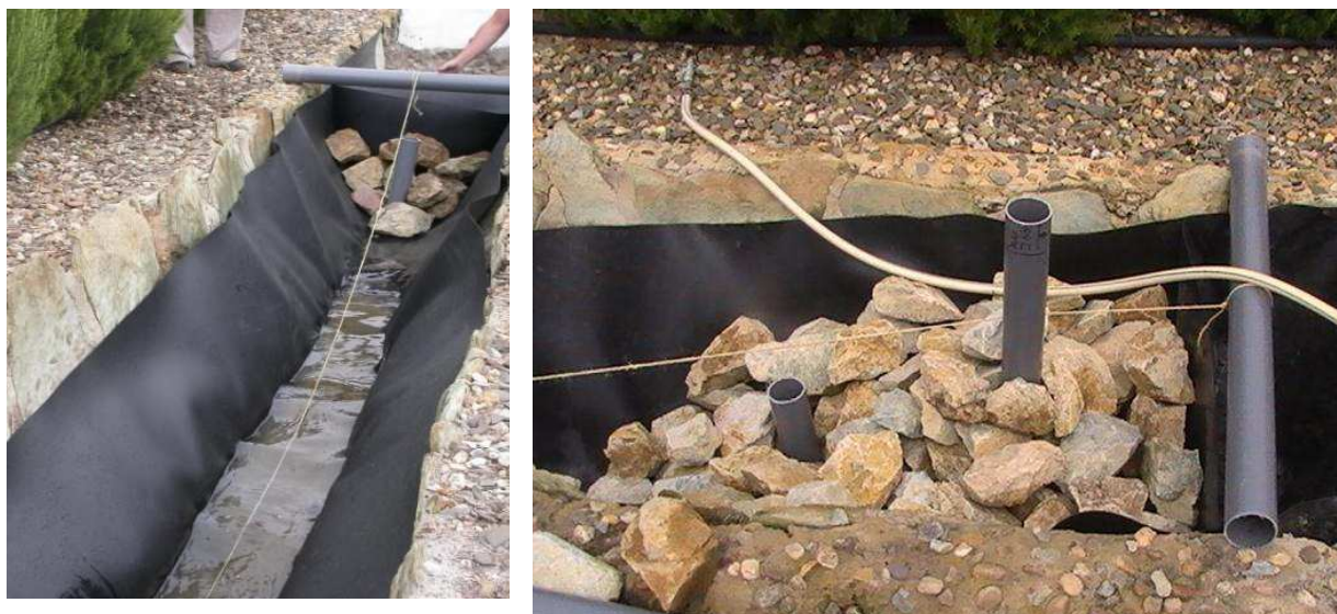
Imagen 29. Trazado de la diagonal para la colocación de piedras.
