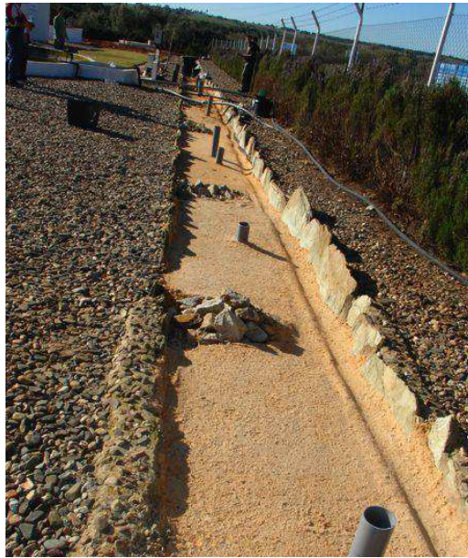
Imagen 35. Dren con arena compactada y canal de escorrentías.
