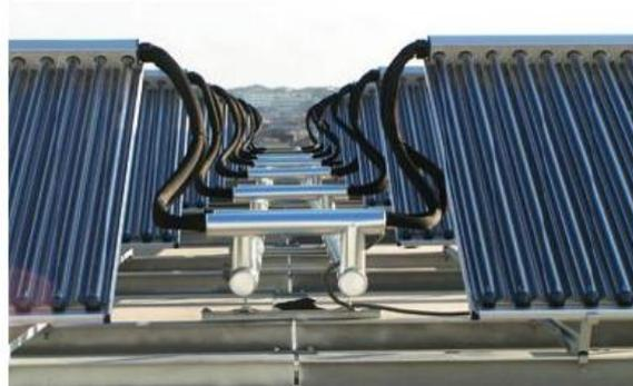
*Figura 19: Captadores de tubo de vacío*
