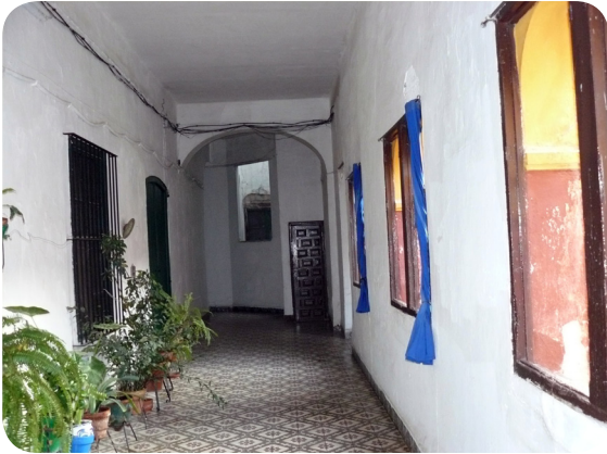
Pasillo con viviendas de los vecinos.
