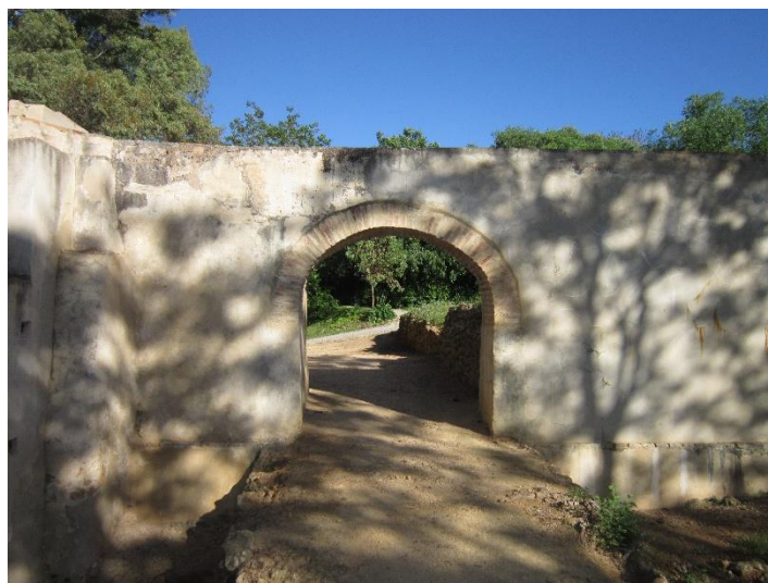
Figura 40: Arcos realizados mediante encofrados
