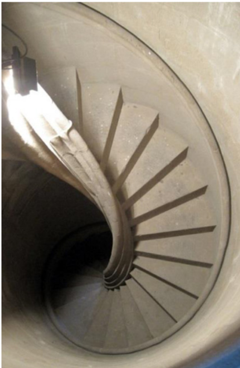
Figura 6. Escalera de caracol con acceso desde la Capilla de San Fernando.
