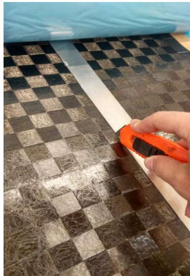
Figura 3-12. Proceso de corte del material
