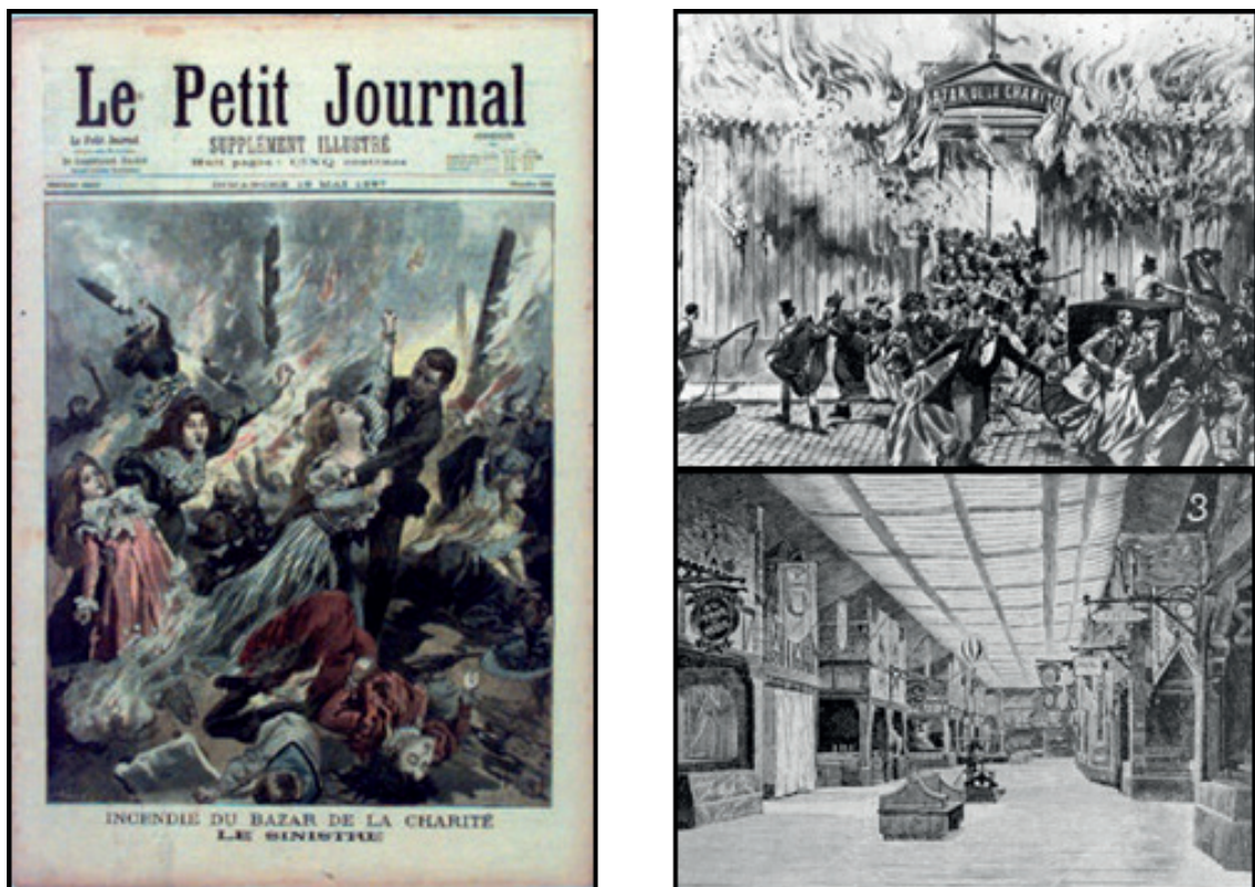
Figura 3 Imágenes del incendio del bazar de la Caridad. (2)
