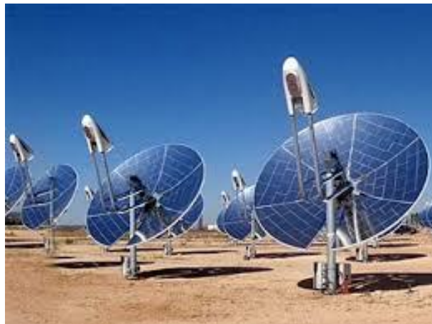
Figura 2-5 Campo de discos solares Stirling situado en Villarobledo (Albacete) (cortesía de Ecología Verde)
