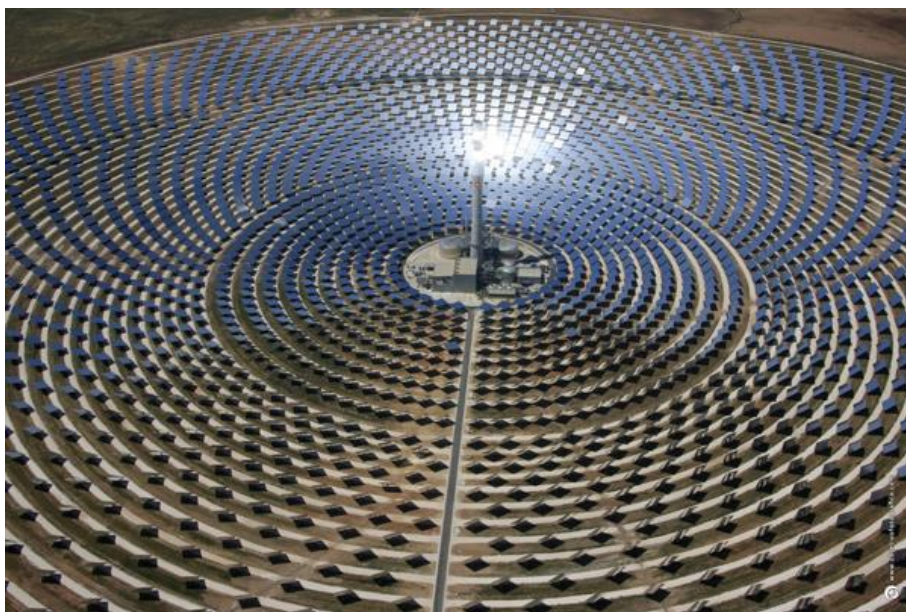
Figura 1-2 Planta solar de torre Gemasolar en Fuentes de Andalucía (Sevilla) (cortesía de Torresol Energy)
