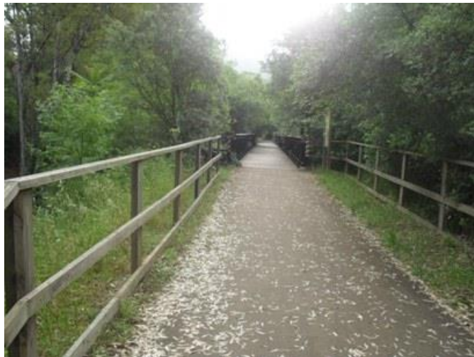
Figura 1.15. Tramo de la Vía Verde del Geoparque Sierra Norte de Sevilla.
