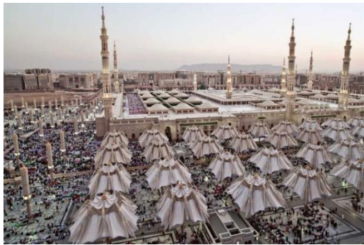
Fig. 80. Sombrillas en la Medina del Santo Profeta en Arabia Saudí. Estructura metálica y móvil mediante motores eléctricos. Membrana de cobertura de PTFE
