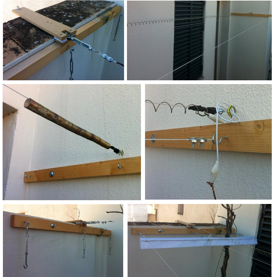
Fig. 190. Detalles de sujeción de toldo con muelle NiTiCu, tensores y extensión con polea para guiado de carga de camino de vuelta
