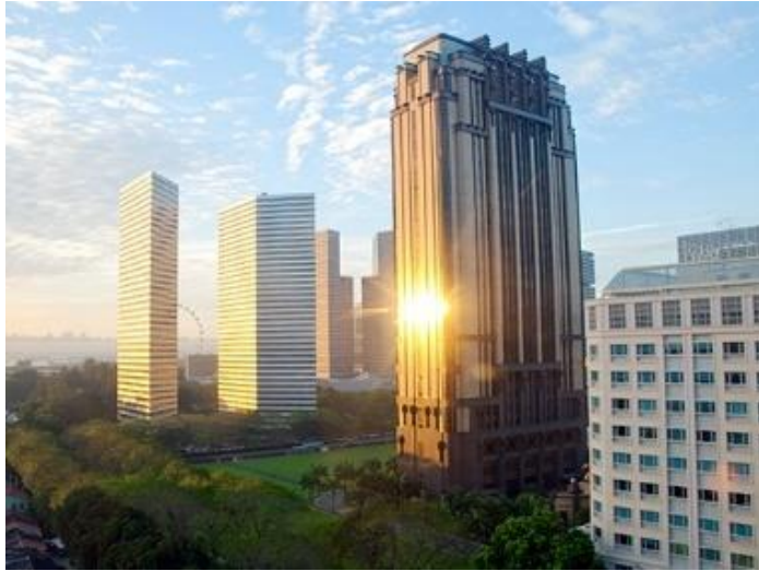
Fig. 11. Edificios con fachadas expuestas al sol
