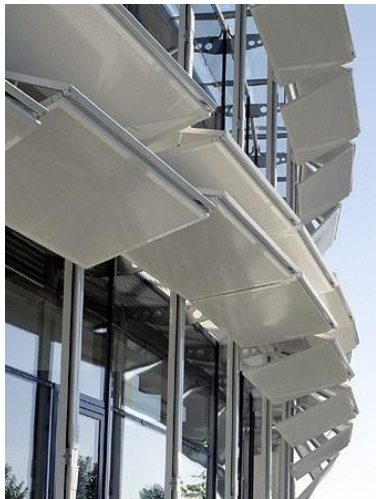
Fig. 72 Showroom Kiefer Technic. Sistema de fachada de paneles móviles
