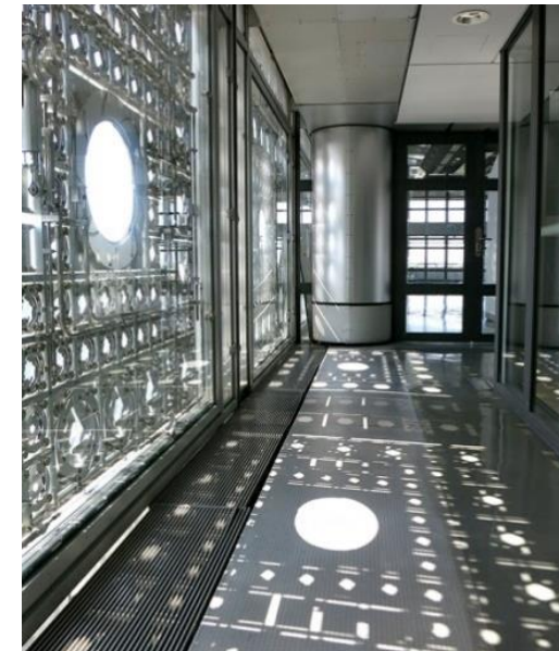
Fig. 70 Detalle del interior con la luz natural entrando por los diafragmas robotizados
