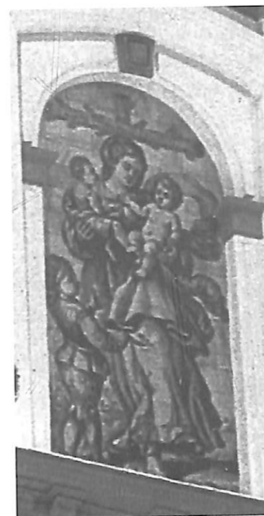
Fig. 10. Caridad Azulejo de la Fachada.
