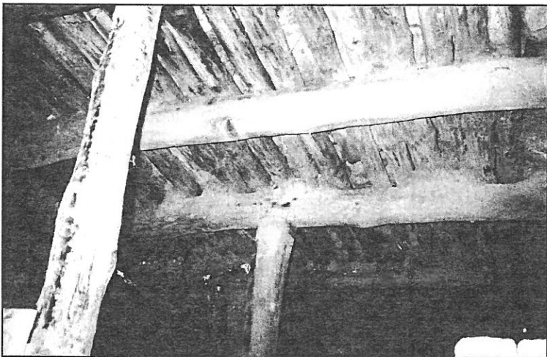
Lámina I: Valcargado. Pozo entibado con madera. Foto M. Valor (1995).
