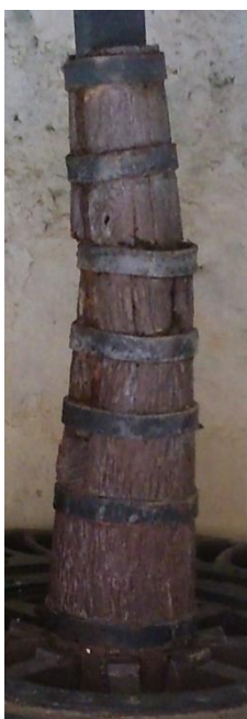
Figura 86 Árbol de una de las paradas del molino de Inca en mal estado.
