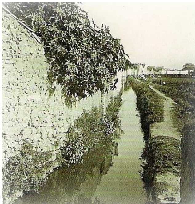
Figura 30 La Tajea: obras realizadas para la conducción de las aguas de los manantiales torremolinenses hasta Málaga.
