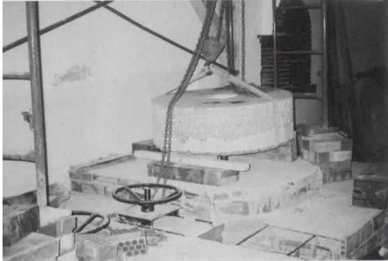
Figura 60 Colocación de la solera. Foto tomada de (8).
