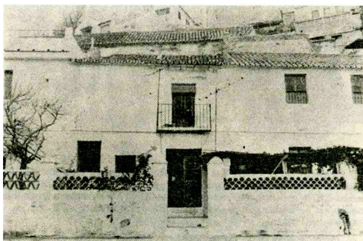
Figura 52 Fachada exterior del Molino de la Esperanza, imagen tomada de (12).
