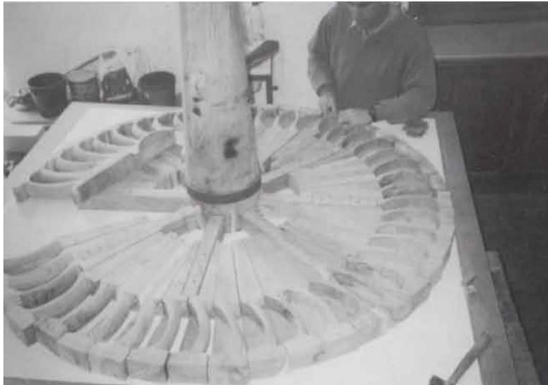
Figura 58 Acoplamiento de las cucharas del rodezno. Foto tomada de (8).
