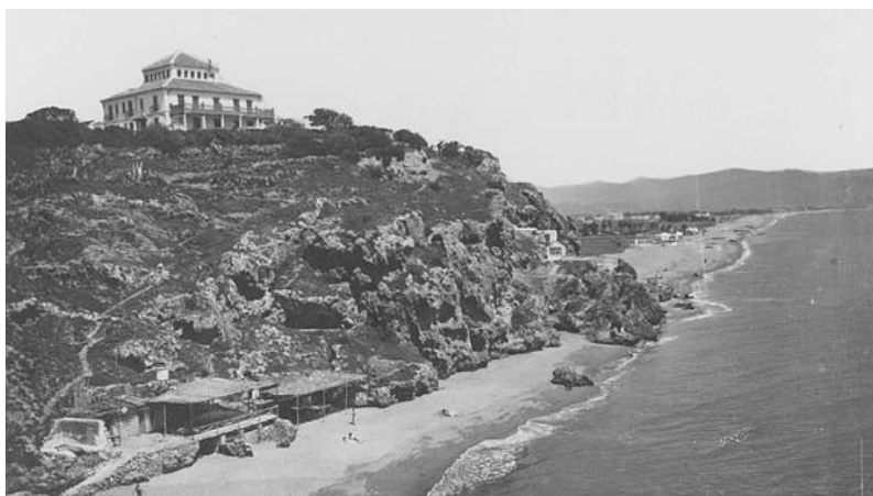
Figura 31 El Castillo del Inglés, Torremolinos en los años 50. Imagen tomada de (15).
