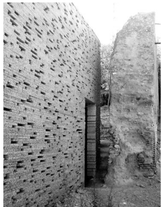
Figura 6. Restauración de la muralla nazarí del Albaicín.
