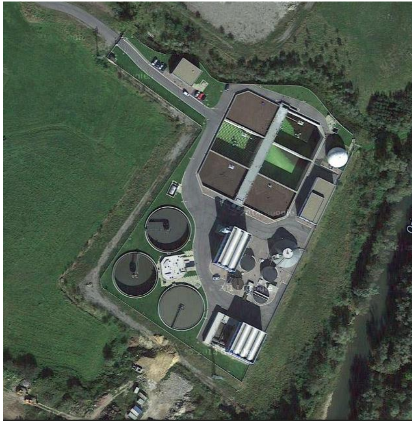
Figura 7.2. Planta depuradora de agua GURAK en Aduna, Guipúzcoa.
