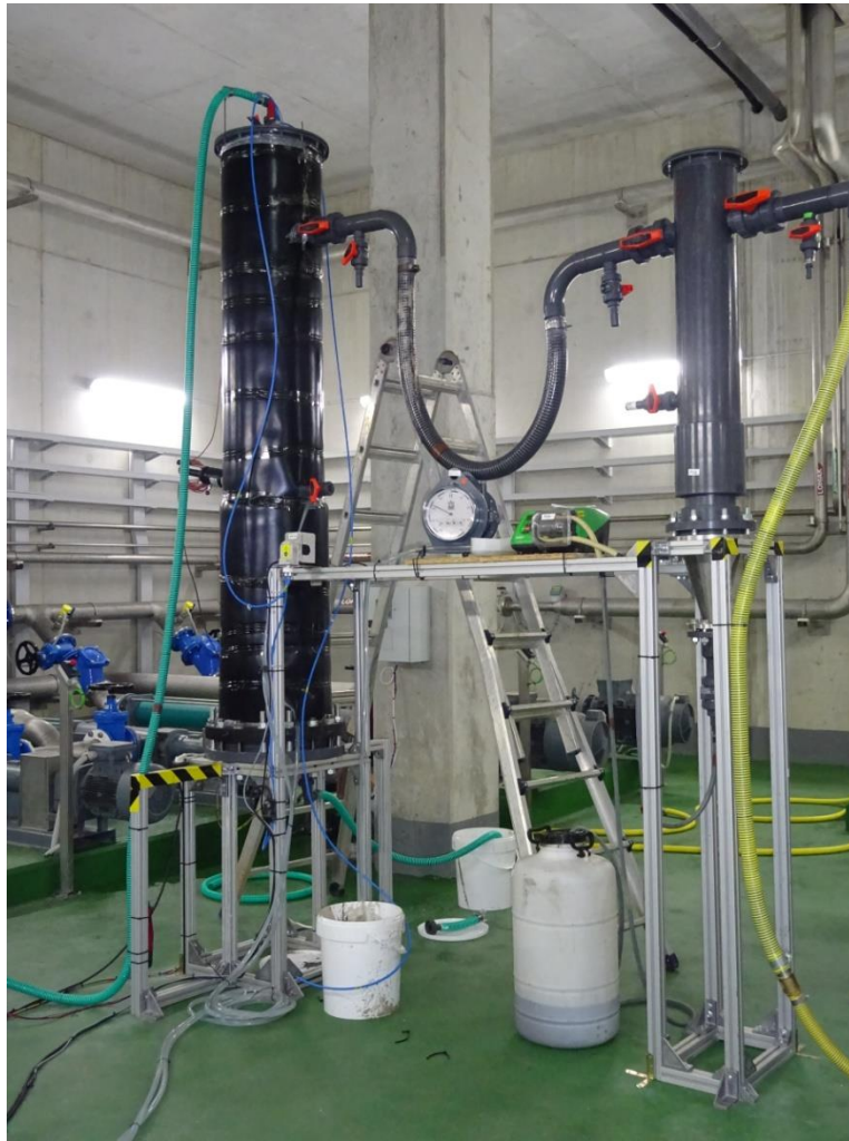
Figura 2.11. Imagen del montaje del subsistema HA-AD
