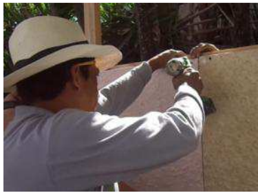
Fig. 8 “Perforacion y anclaje de tableros”.
