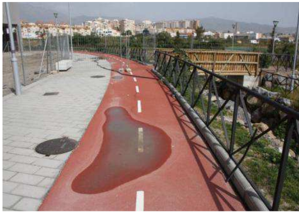
Fig 4 “Asentamiento y cambio de pendiente” y Fig 5 “Caída de rocas en la escollera del canal”
