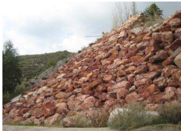
Fig 6 “Muro de escollera deficiente” y Fig 7 “Movimiento del terreno y deslizamiento del muro”.
