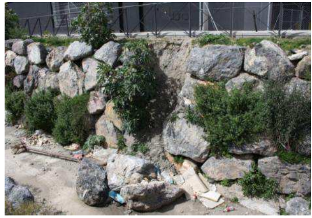
Fig 4 “Asentamiento y cambio de pendiente” y Fig 5 “Caída de rocas en la escollera del canal”
