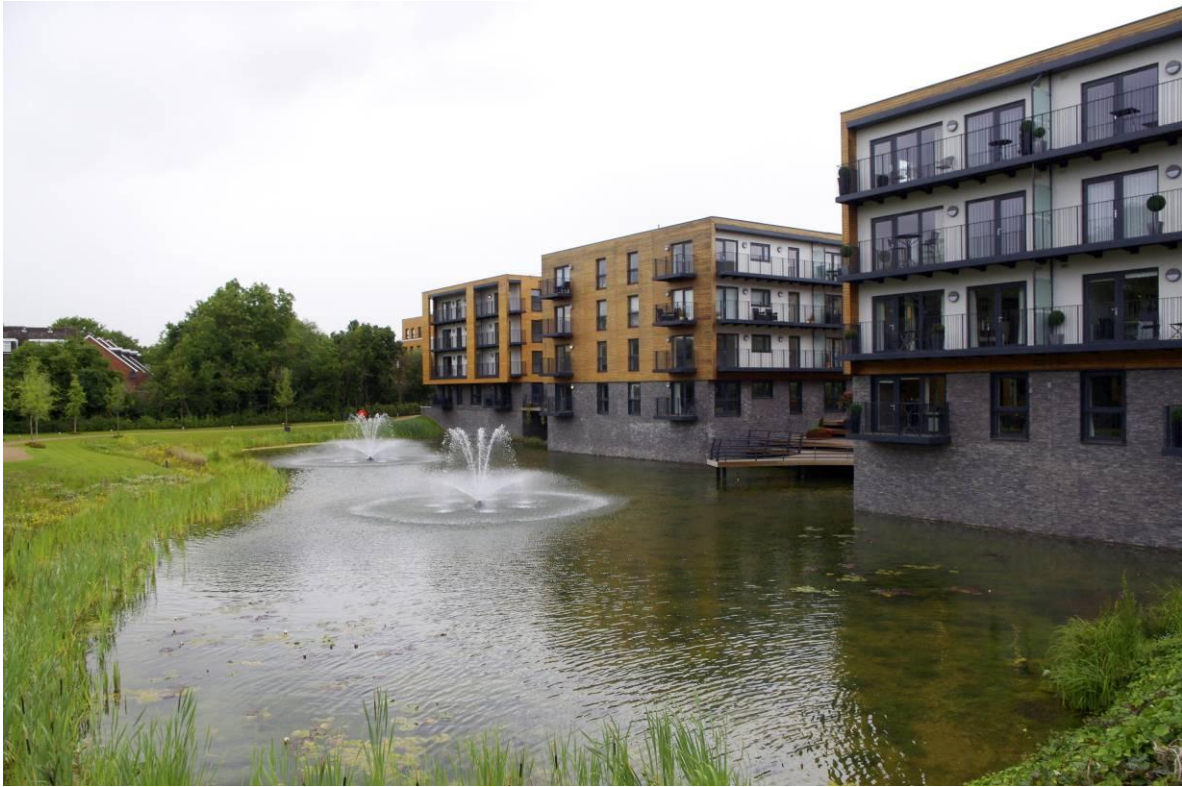
Fig.1. Lago artificial en complejo residencial - depósito de almacenamiento para crecidas y agua de lluvia.
