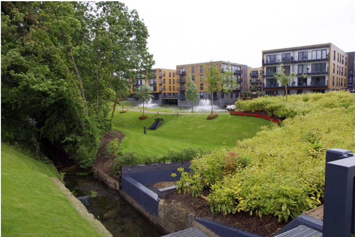
Fig. 2. El conducto conectando el canal natural con el lago artificial.
