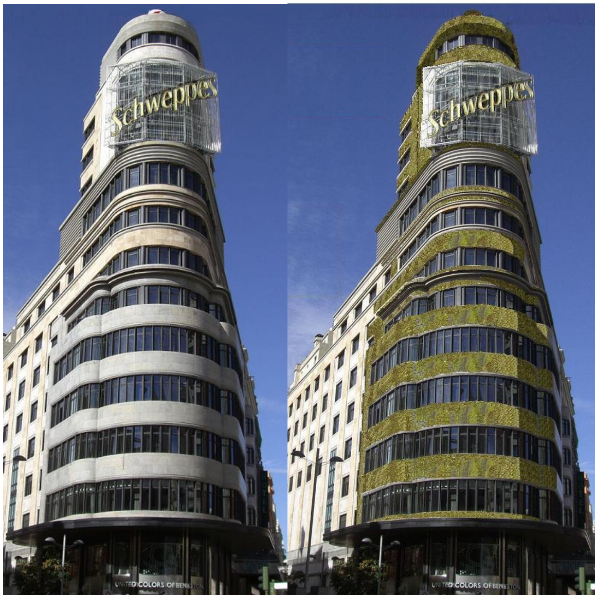
Fig. 5 y 6 “Edificio Carrión, Gran Vía de Madrid. Fuente: Edificio Carrión, Gran Vía de Madrid. Fuente: Montaje en Adobe Illustrator CS6 por José Antonio Noguera García.
